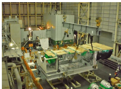
新しいガスタービン設備の 吊り上げ作業
