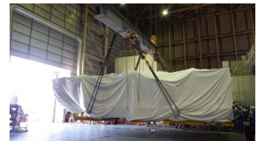
新しいガスタービンの吊り上げ作業
