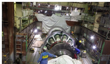
新しいガスタービンの組み立て作業
