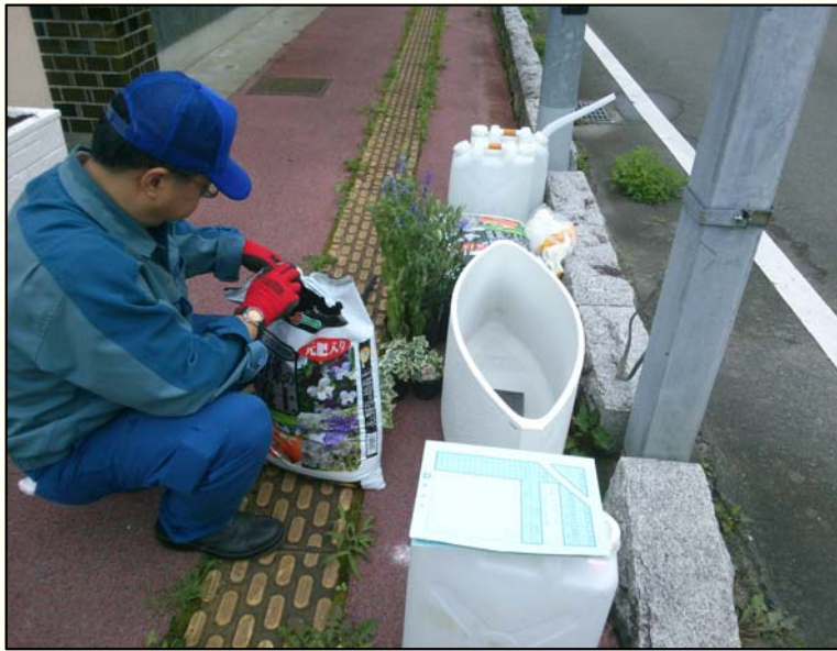
植込み作業(南相馬市)【平成25年8月5日】
