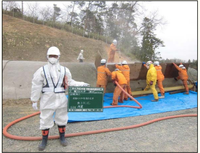
【法面コンクリート部高圧水洗浄の様子】
