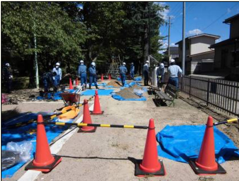
【簡易除染の様子】
