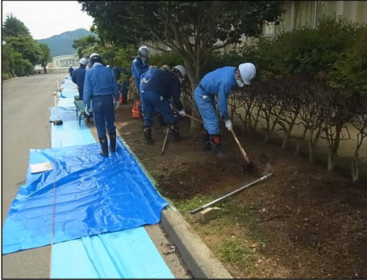
【簡易除染の様子】
