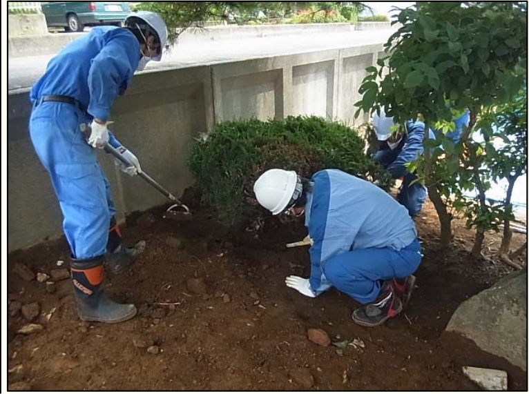
【簡易除染の様子】
