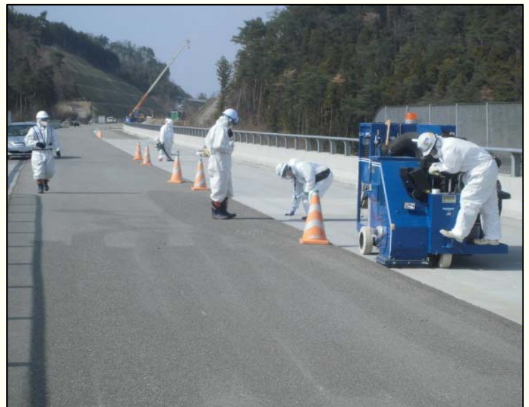
【橋梁部ブラスト作業の様子】
