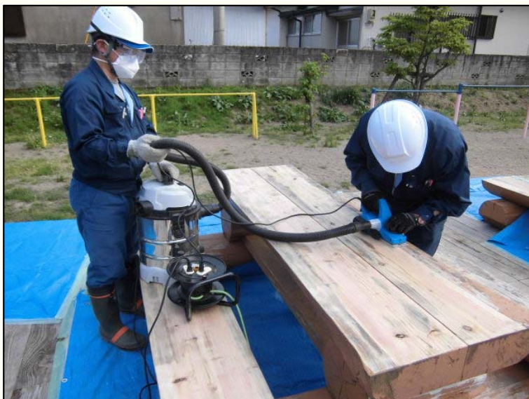
【簡易除染の様子】
