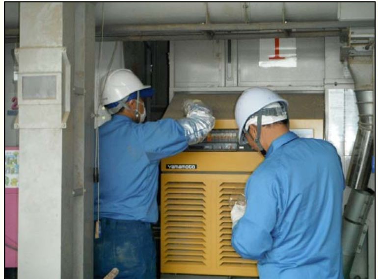
【機械表面の汚染測定の様子】
