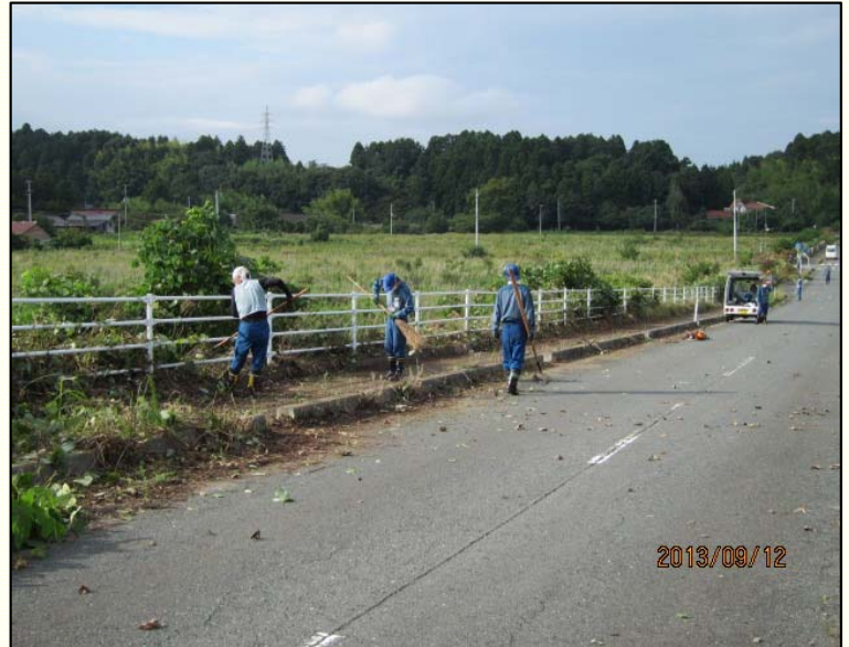
除草後の清掃【平成25年9月12日】
