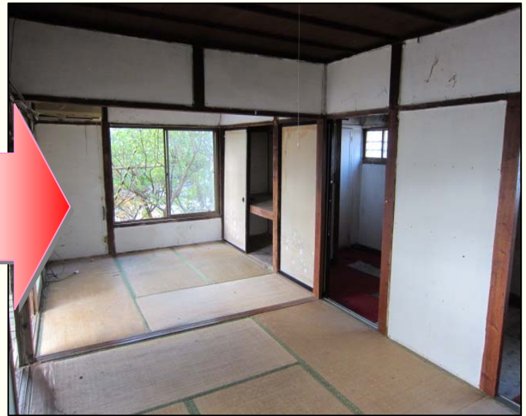
片付け後の様子【平成25年12月4日】
