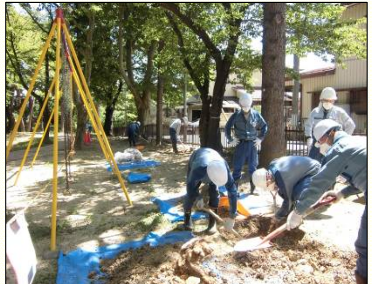
【簡易除染の様子】
