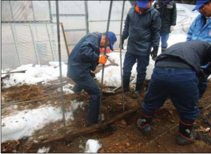
ビニールハウス解体の状況（田村市）[平成26年3月撮影]
