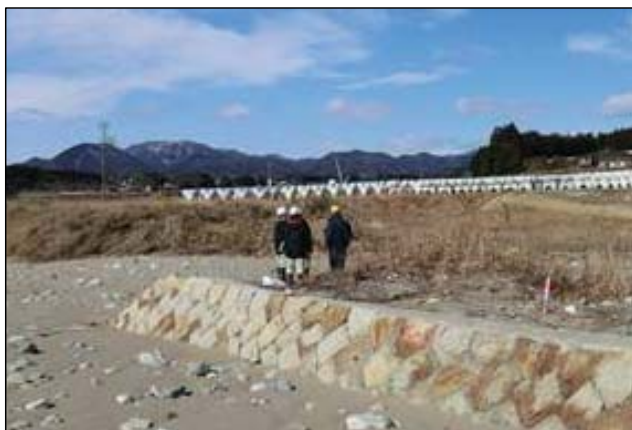
現地調査状況
