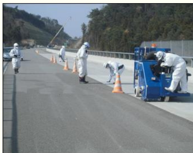
【橋梁部ブラスト作業の様子】
