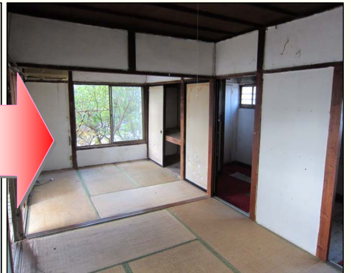
片付け後の様子【平成25年12月4日】
