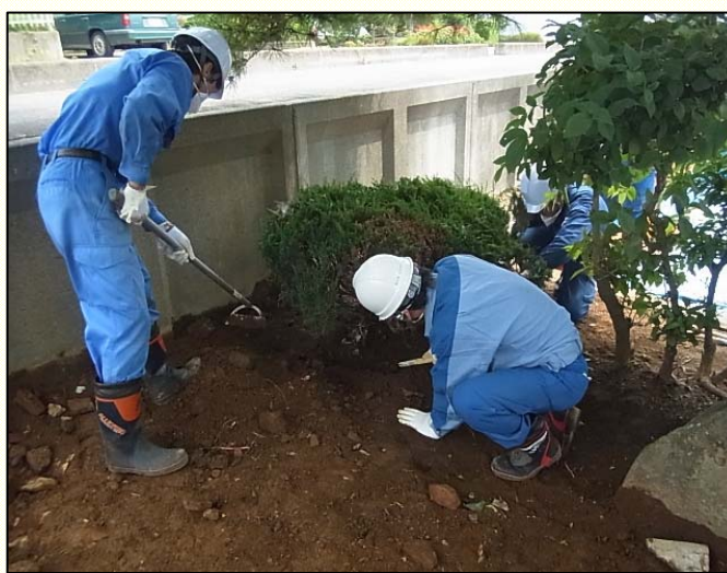
【簡易除染の様子】
