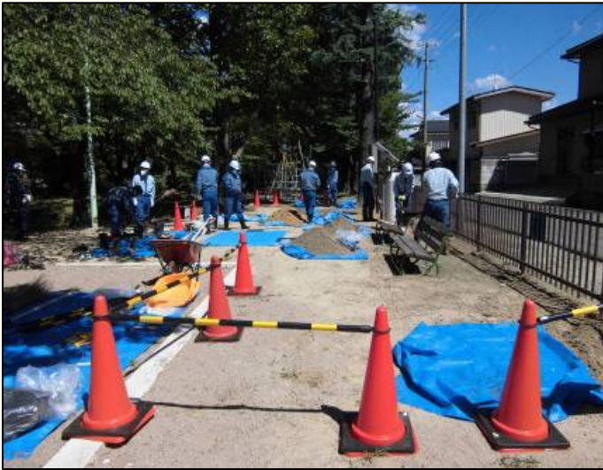
【簡易除染の様子】
