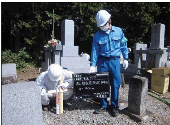
砂利の剥ぎ取り前立ち会い
