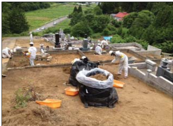
除染作業（表土剥ぎ）の様子
