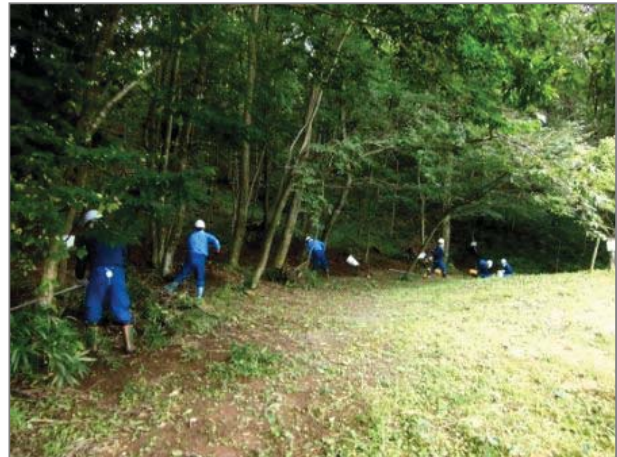
除染作業状況(隣接する林縁部)
