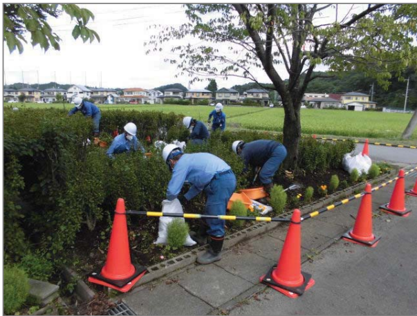
除染作業状況(植栽部)
