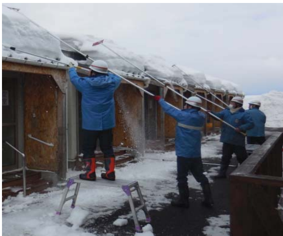
仮設住宅の雪おろしの様子 [平成27年 2月撮影]
