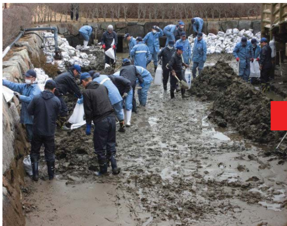
泥あげ（土嚢袋へ格納）の様子[平成27年2月23日撮影]
