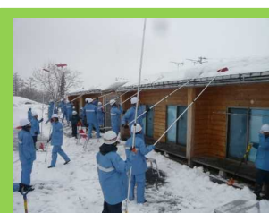
仮設住宅の雪下ろし
