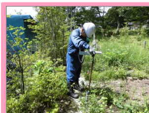
フォローアップ除染前の現地調査
