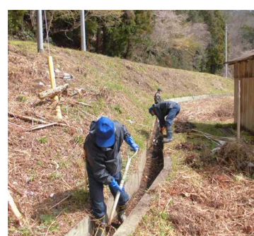
泥あげの作業
