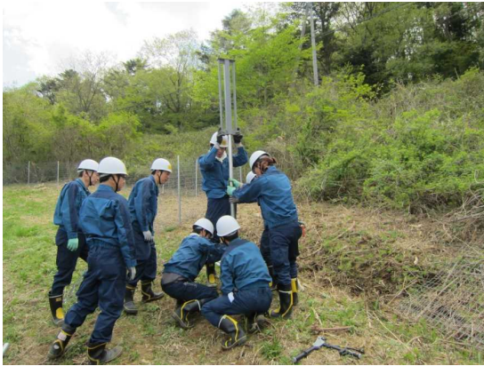
支柱打ち込みの様子[2015年4月24日撮影]
