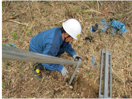
支柱取り付けの様子[2015年4月24日撮影]
