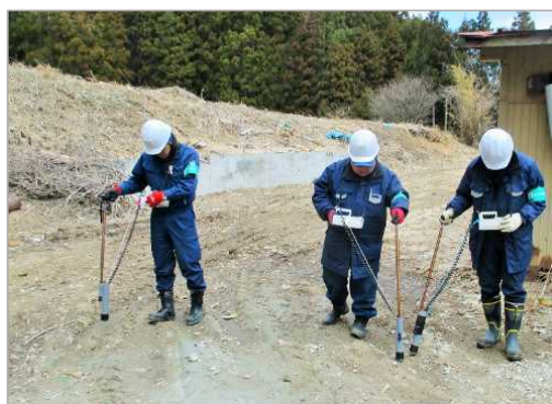
現地調査状況（家屋付近）
