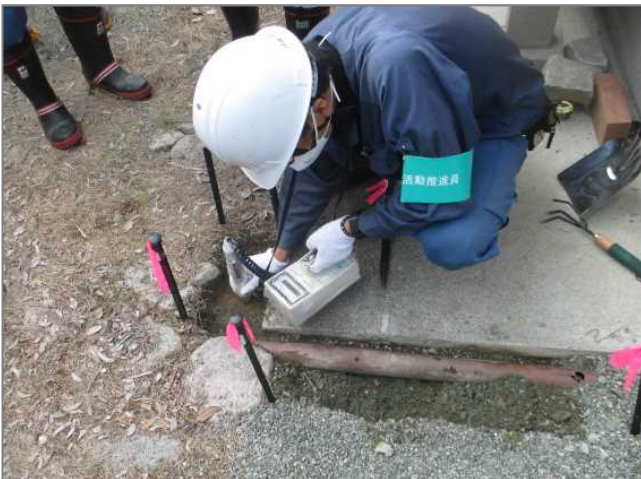
現地調査状況
