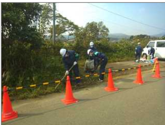
堆積物・土壌等の除去作業状況
