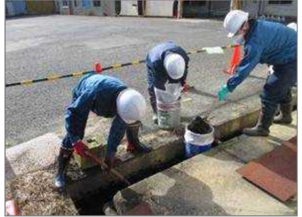
屋外の側溝部 除染作業状況
