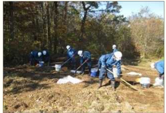
【除染作業の様子】
