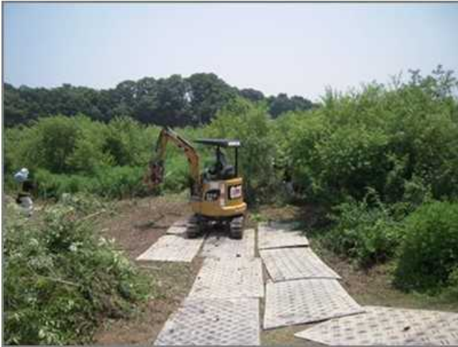
【柳等の除去作業】
