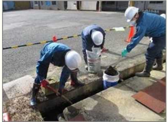
【屋外の側溝部 除染作業状況】
