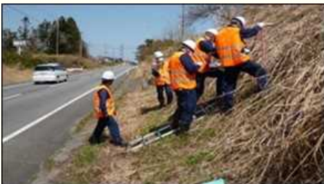
【現場調査の様子】
