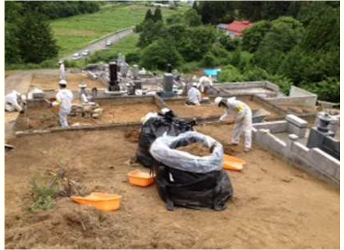
【除染作業（表土剥ぎ）の様子】
