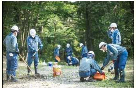
【除染作業の様子】
