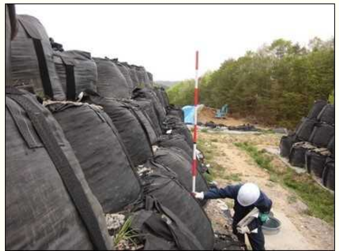
【遮蔽土のう状態調査の様子】
