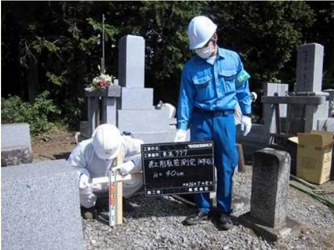
【砂利の剥ぎ取り前立ち会いの様子】
