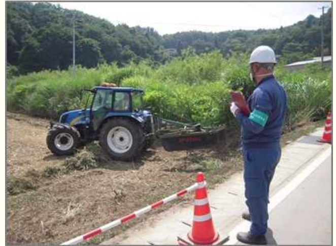
【現場対応状況】
