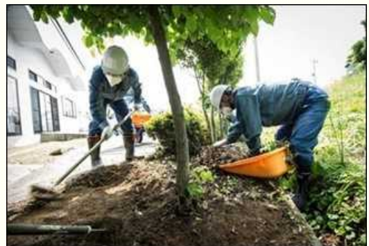
【除染作業の様子】
