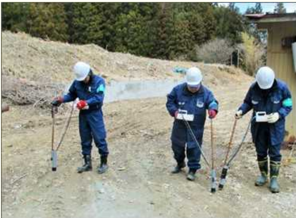
【現地調査状況（家屋付近）】
