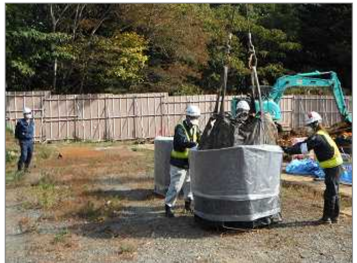
現場状況 その2
