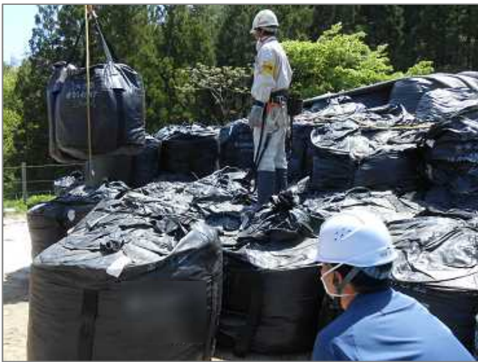
現場状況 その1
