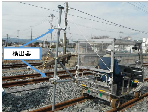
線路上モニタリング状況
