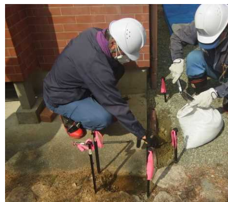
土壌除去状況（楡葉町）
