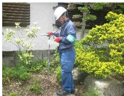
不安箇所の調査状況
