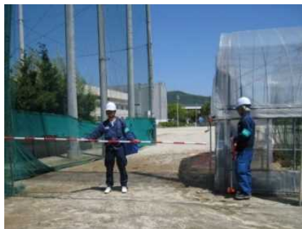
搬出時の障害物調査状況
