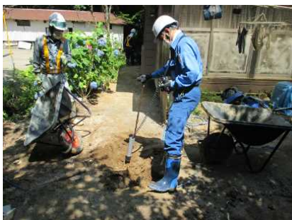
除染作業中の線量確認状況
