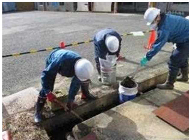
【屋外の側溝部 除染作業状況】
