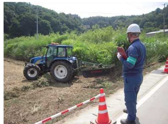
【現場対応状況】
