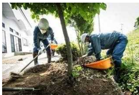
【除染作業の様子】
