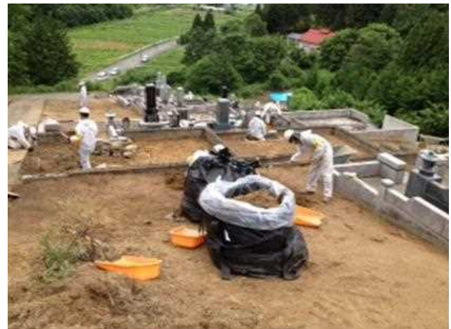
【除染作業(表土剥ぎ)の様子】
