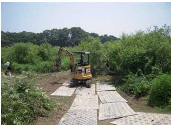
【柳等の除去作業】
