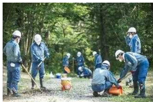
【除染作業の様子】
