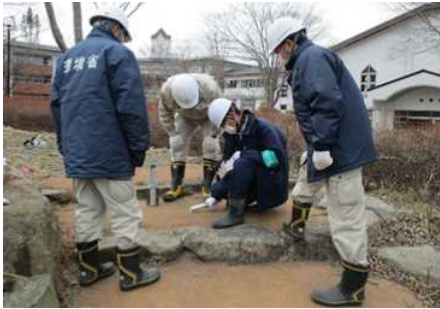
【飯館村モニタリング状況】 （除染前の現地調査）
