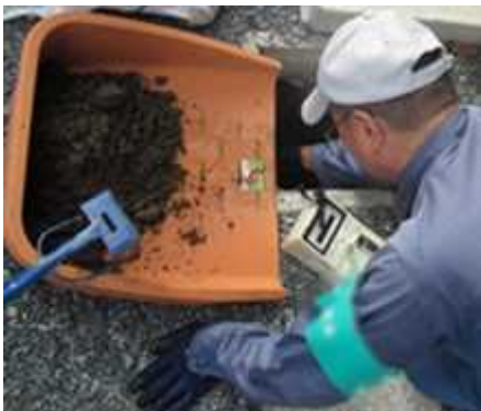
【簡易土壌除去状況（南相馬市）】
