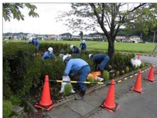
【除染作業の様子】
