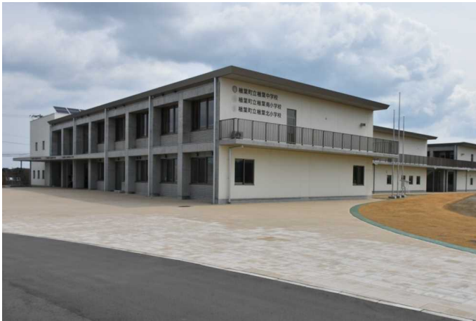
新校舎の外観[2017年3月28日撮影]
