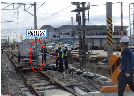
線路上モニタリングの状況
