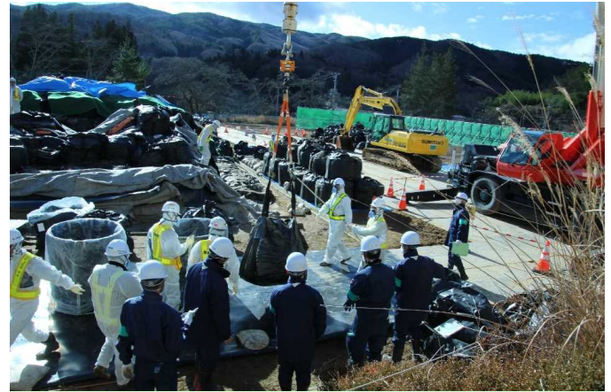
保管容器内収納状態の確認
