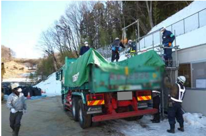
荷台遮水対策の実施状況確認
