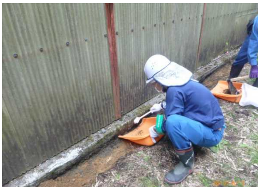
【簡易土壌除去状況(川俣町)】
