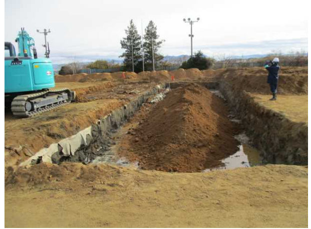
【埋め戻し前の線量確認状況】
