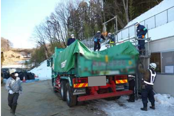
【荷台遮水対策の実施状況確認】
