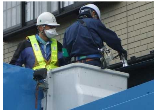
【現地調査状況(浪江町)】
