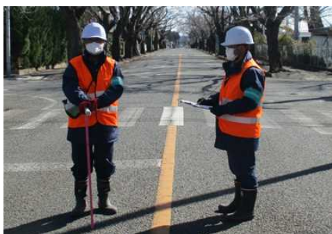
【本格除染後の線量確認状況(1)】
