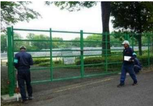
【現場調査状況（仮置場入口の寸法確認）】
