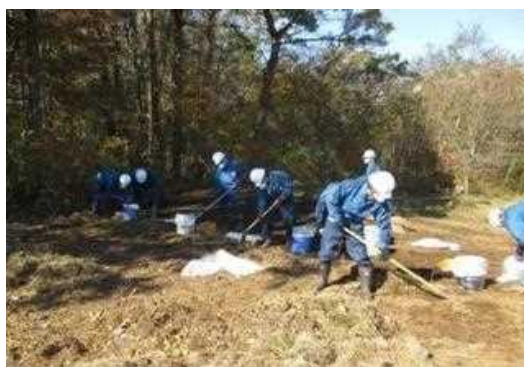
【除染作業の様子】
