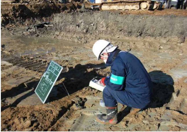
【埋め戻し前の線量確認状況】
