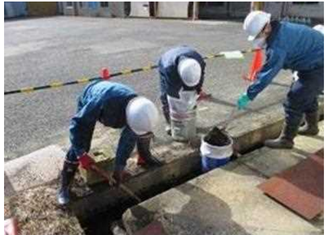
【屋外の側溝部 除染作業状況】
