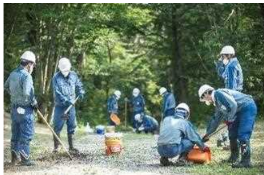
【除染作業の様子】
