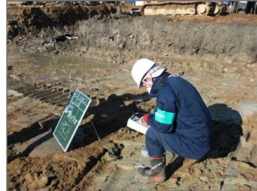
埋め戻し前の線量確認
