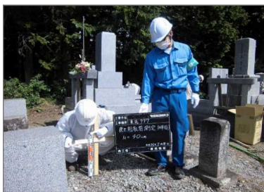
砂利剥ぎ取り時の 確認作業
