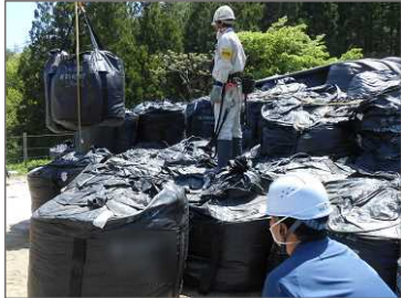
仮置場の解体・搬出時 工事監督補助
