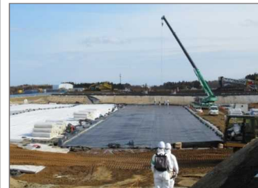
土壌貯蔵施設（遮水工）の 現場確認
