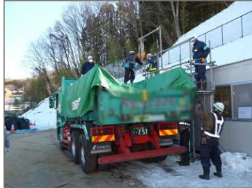
荷台遮水対策の実施状況 確認
