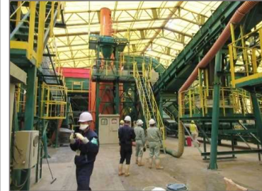
受入・分別処理施設の 現場確認
