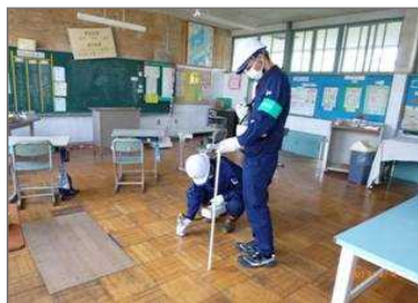
解体工事着手前の モニタリング
