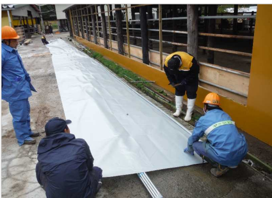
シート張りの様子②[2018年10月12日撮影]
