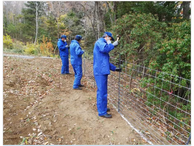
設置作業の様子[2018年11月30日撮影]
