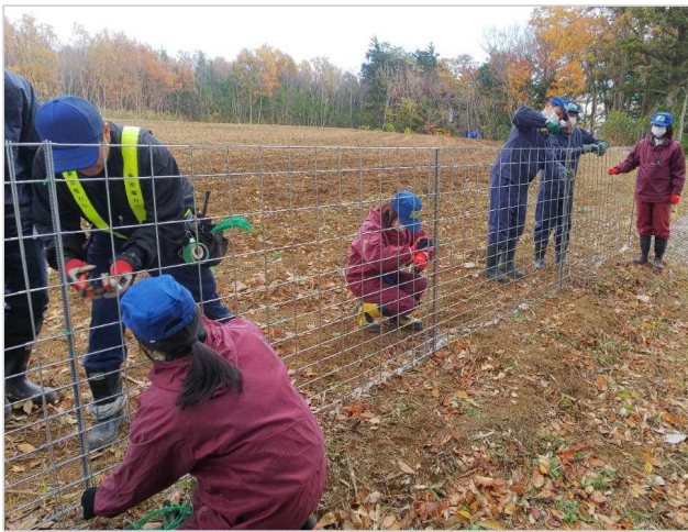
設置作業の様子[2018年11月30日撮影]
