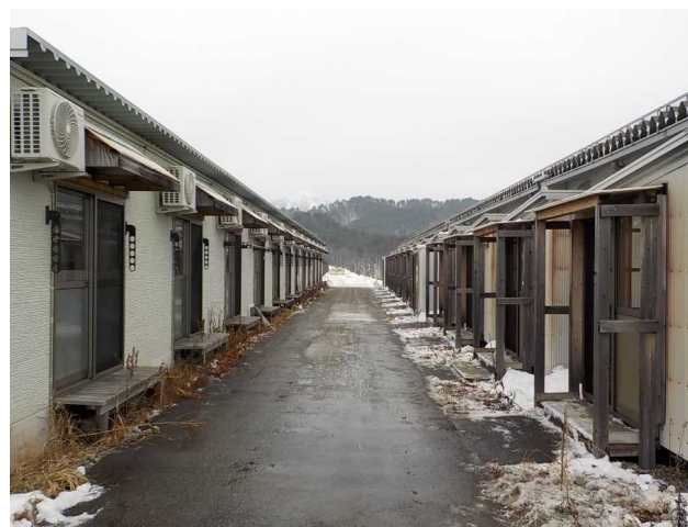
作業後の様子[2019年2月6日撮影]
