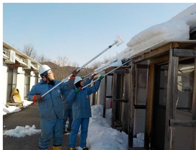
屋根雪下ろしの様子[2019年2月5日撮影]
