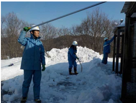
大熊町会津若松応急仮設住宅の屋根雪下ろしへの協力
