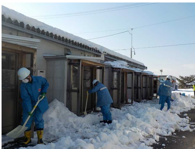
屋根雪下ろしの様子[2019年2月5日撮影]
