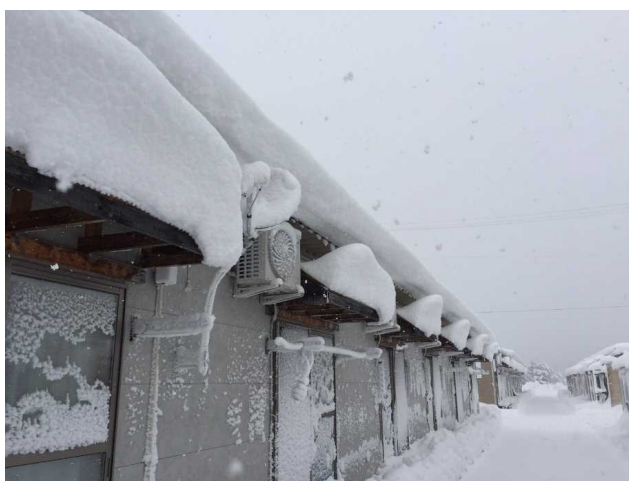
作業前の様子[2019年1月29日撮影]
