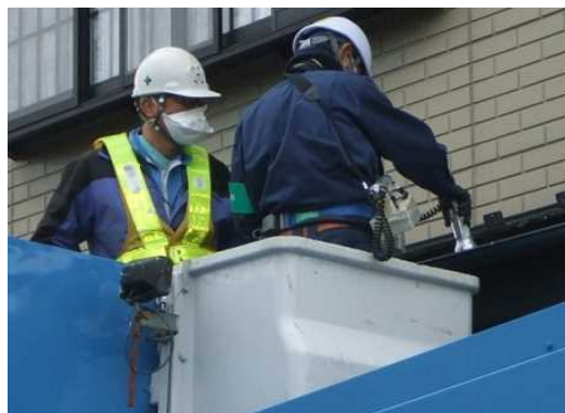
【現地調査状況(浪江町)】
