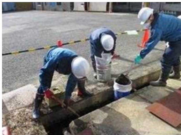
【屋外の側溝部 除染作業状況】
