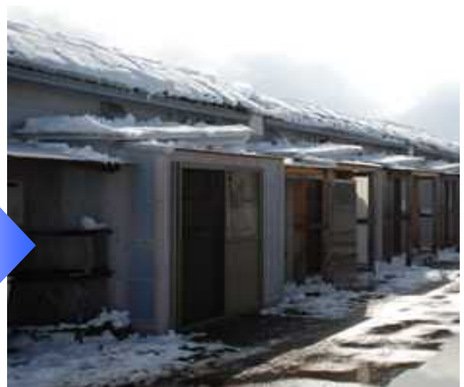
【除雪後の様子】(2017年2月)
