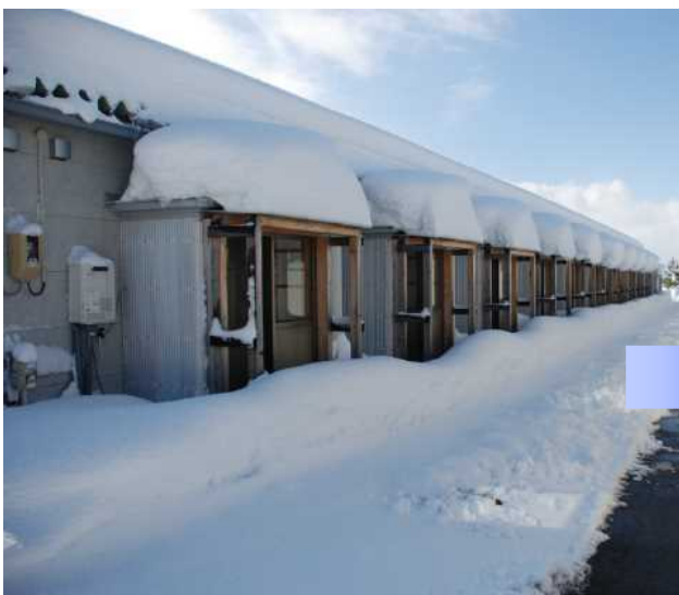
【除雪前の様子】(2017年2月)
