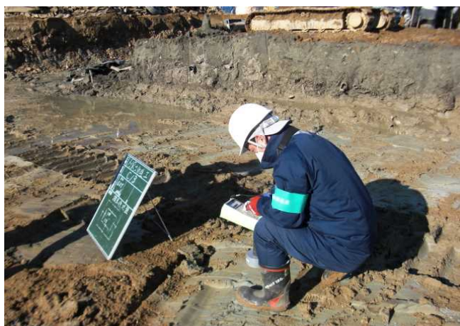
【埋め戻し前の線量確認状況】
