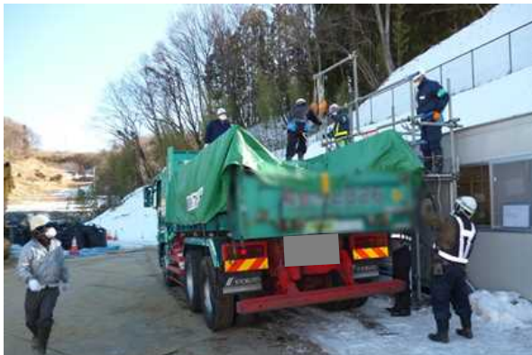
【荷台遮水対策の実施状況確認】
