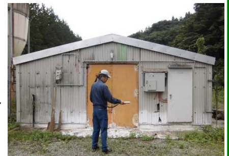
【モニタリング状況(鶏舎周辺)】
