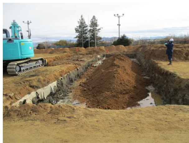
【埋め戻し前の線量確認状況】
