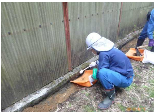
【簡易土壌除去状況(川俣町)】
