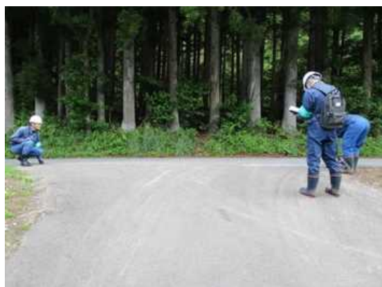
輸送ルートの幅員測定状況
