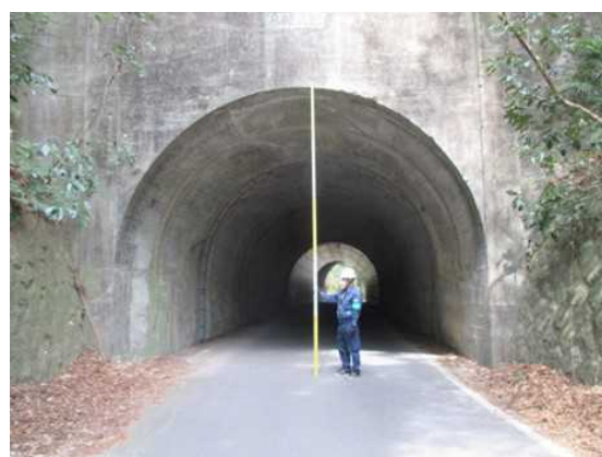
輸送ルートの支障物高さ測定状況
