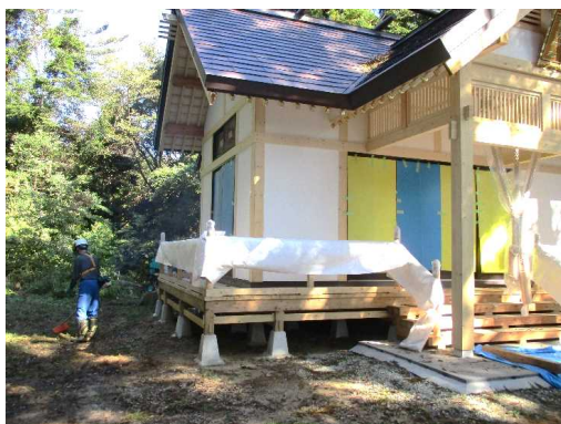
完成前の社殿と除草の様子 [2019年10月28日撮影]
