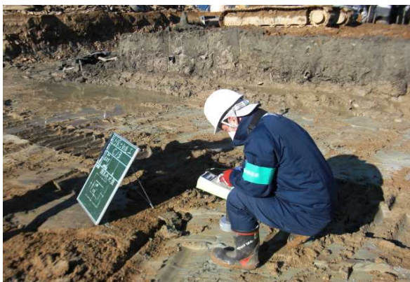
【埋め戻し前の線量確認状況】
