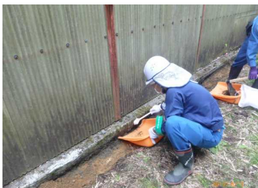
【簡易土壌除去状況(川俣町)】
