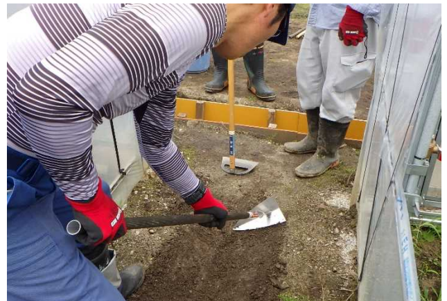
【側溝掘りの様子】(2019年6月27日)
