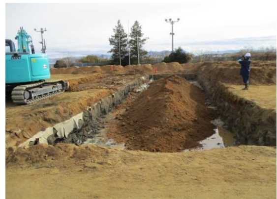
【埋め戻し中の確認状況】
