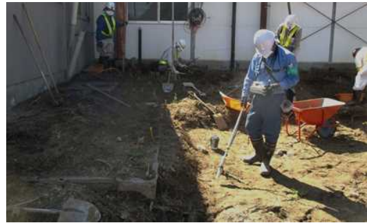
【浪江町モニタリング状況】 (除染中の線量確認状況)
