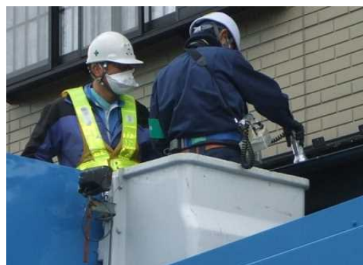
【現地調査状況(浪江町)】
