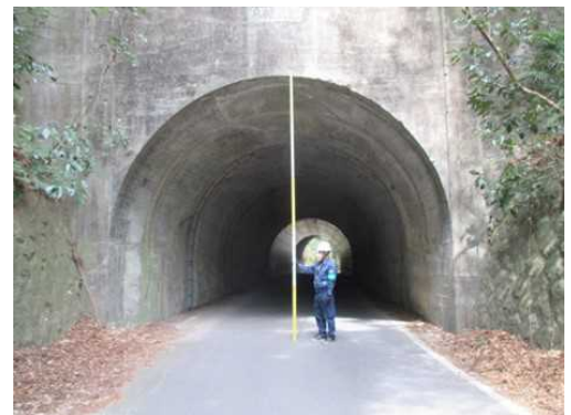
【輸送ルートの支障物高さ測定状況】
