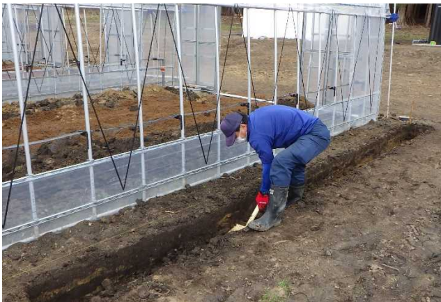
【側溝掘りの様子】(2019年4月19日)
