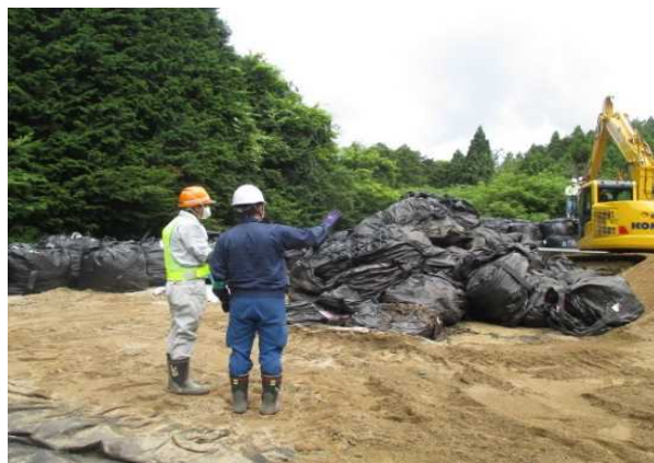
②施工中の状況確認
