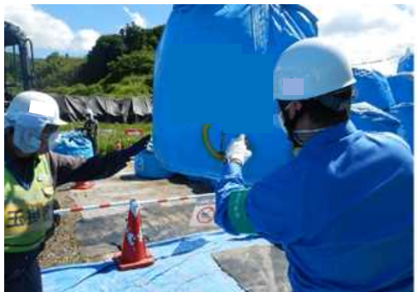
③保管容器の状態確認
