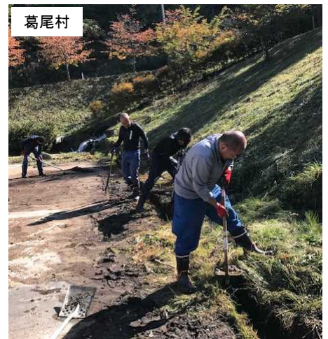
側溝の泥上げ [2019年10月17日撮影]
