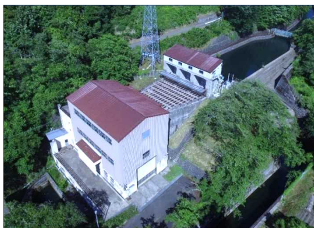
<既設の発電所建屋（工事なし）>
