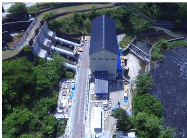
<改修後の発電所建屋>
