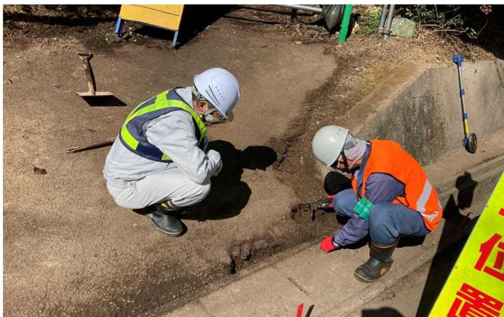
除染範囲を確認するための試掘作業の様子
