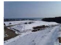
1 槽目の状況 (1/16撮影)
