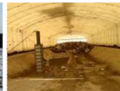
2 槽目の状況 (1/16撮影)
