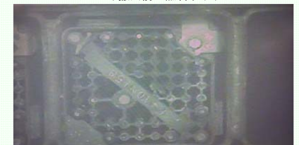
＜ガレキ撤去後の燃料ラック＞
