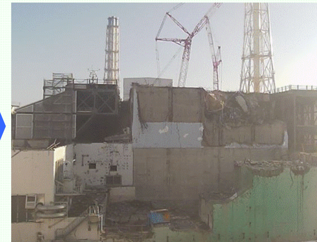
＜ガレキ撤去後の3号機外観＞
