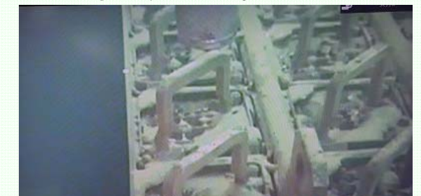
＜ガレキ撤去前の燃料ラック＞
