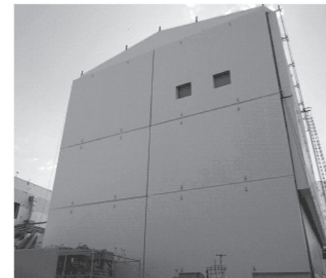
放射性物質の飛散を抑制する原子炉建屋カバーの設置工事が完了した1号機
