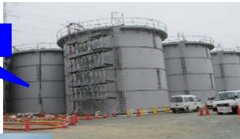
鋼製角型タンク
