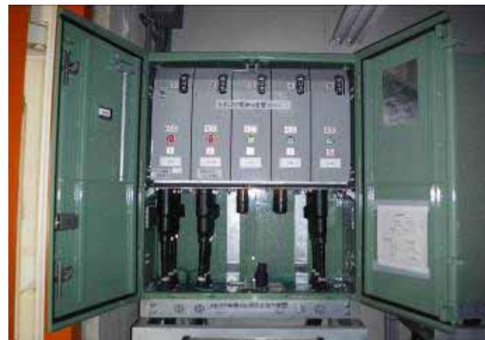
●切替盤追設状況 4号SFP代替冷却(一次系)
