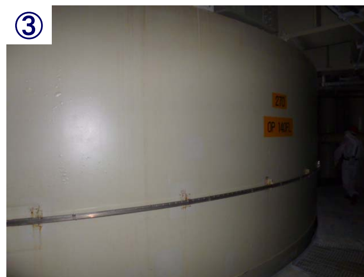
現場状況写真
