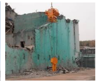
油圧ペンチ 散在がれきの撤去作業に 使用
