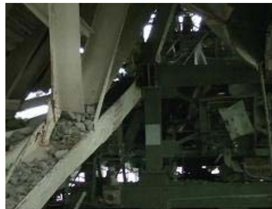
撮影H24.10月(オペフロ バルーン調査)
