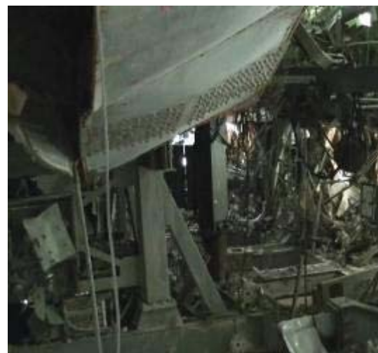
撮影H24.10月(オペフロ バルーン調査)
