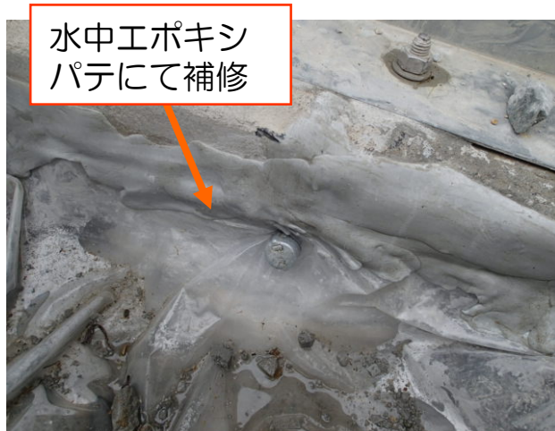
【H5 西側の漏洩箇所の補修状況】
