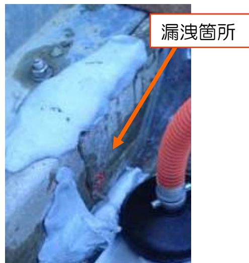
【H5 西側の目地部からの漏洩】
