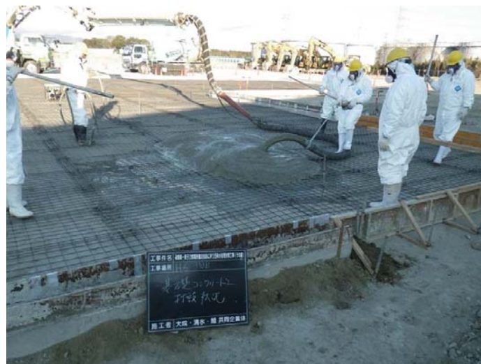
【基礎コンクリート打設（H6）】
