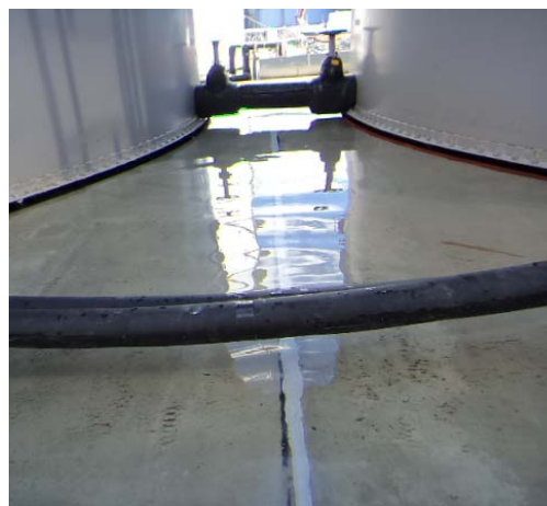
【H5 西側の目地部の補修状況】
