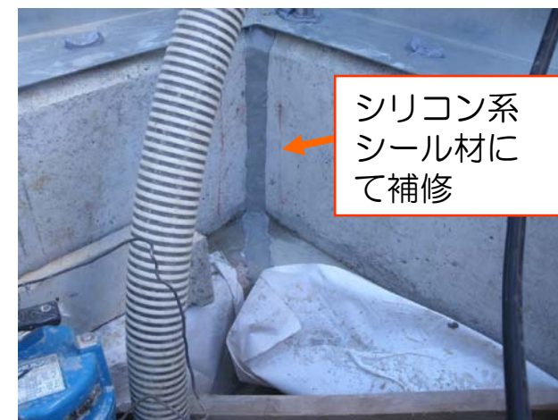
【G6北 北東角部の漏洩箇所の補修状況】
