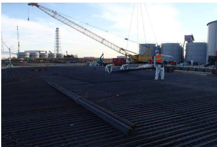
【基礎鉄筋設置（J1）】
