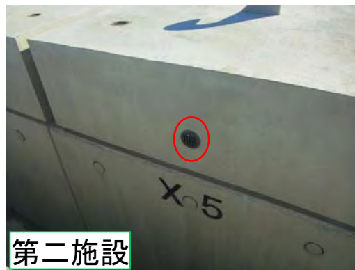
ボックスカルバートの換気口の例
