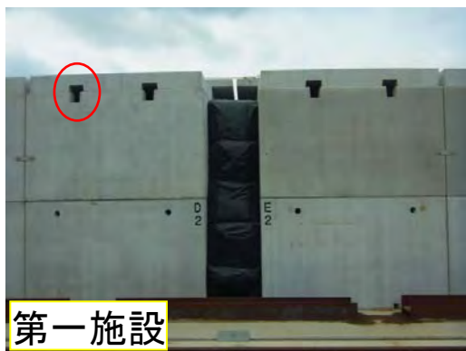
ボックスカルバートの換気口の例
