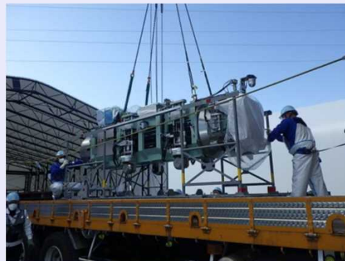
<堆積物除去装置の運搬状況>
