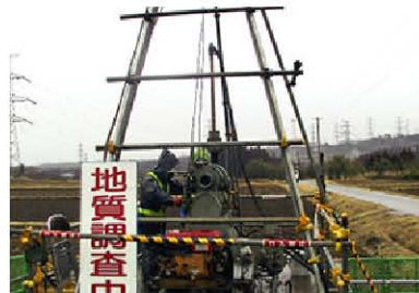
ボーリング調査
