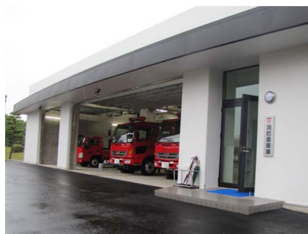
第 8.1.2-2 図 化学消防車（右）水槽付消防車（中央）の配備
