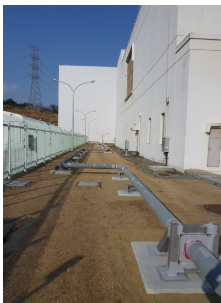
第 8.1.2-3 図 消火配管の地上化
