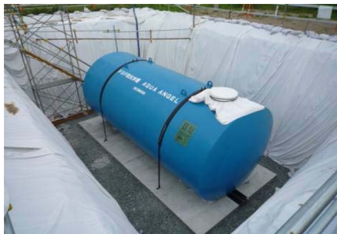
第 8.1.2-4 図 防火水槽の設置
