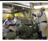
写真は、津波の被害によりモータが使えなくなった 場合でも、すみやかに復旧できるよう「モータ取替 チーム」がモータを取り替える訓練を行っている様子 です。
