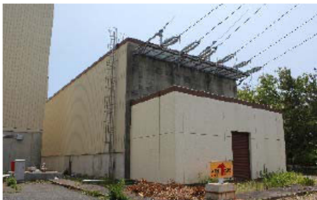
開閉所の外観
