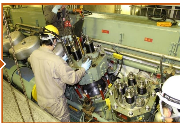
点検中のディーゼル機関（シリンダ部分）の組立
