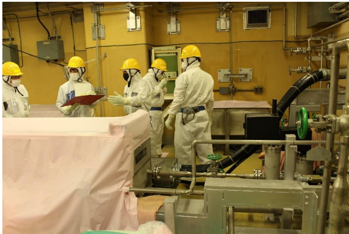
安全点検を実施している様子
